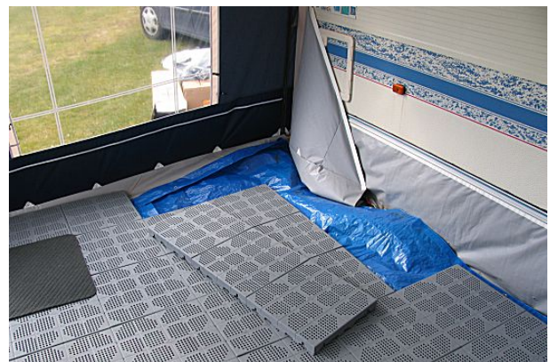
Camper gulvfliser i plast, der er lagt oven på en fugt-afvisende presenning.
